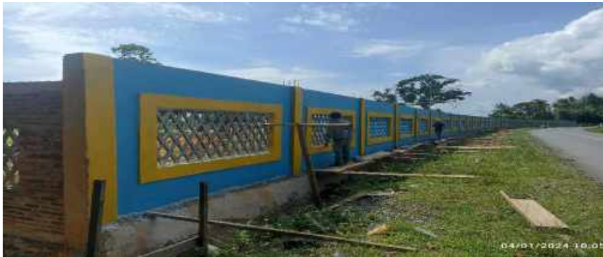
11. Pembangunan Tambahan Menara Jaga
